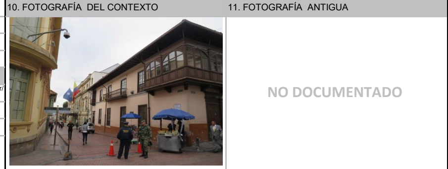
Fuente: Equipo Fotografía PEMP Patrimonio Inmueble Fuente: No documentado
